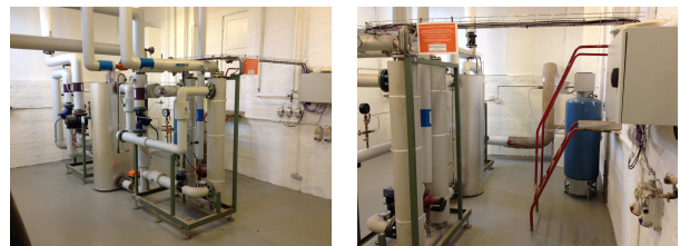
Varmecentral efter renovering
